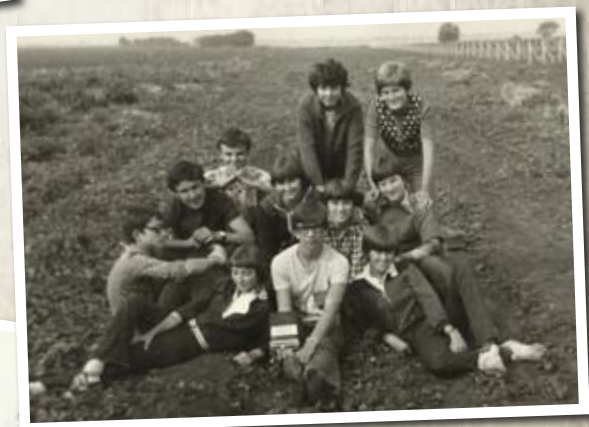
Výstavba bežeckej dráhy v októbri 1984, brigádnici: Sárközi, Caletka, Móder, Hruškár, Ranto, Kulcsár, Ďurčovič, Domaniža.
